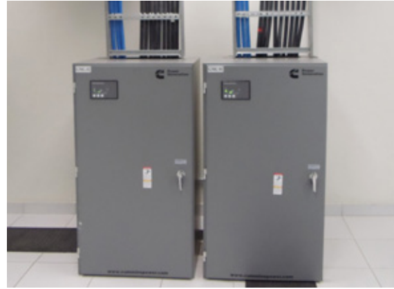
Na primeira imagem, interior da sala de geração com os 2 Grupos Geradores Cummins em funcionamento. Na segunda, Chave de Transferência GTEC garantindo mais confiança ao Datacenter do cliente.
