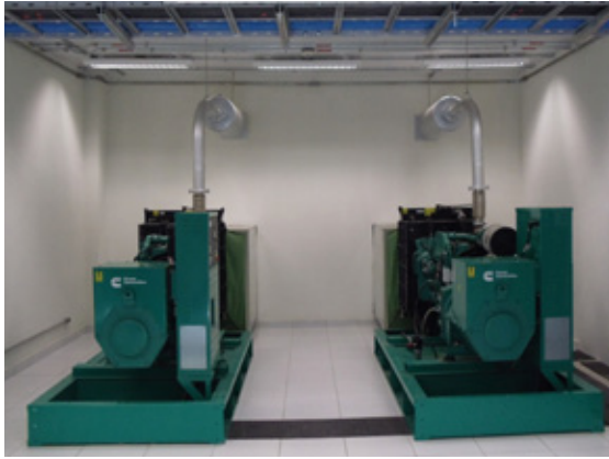
Na primeira imagem, interior da sala de geração com os 2 Grupos Geradores Cummins em funcionamento. Na segunda, Chave de Transferência GTEC garantindo mais confiança ao Datacenter do cliente.
