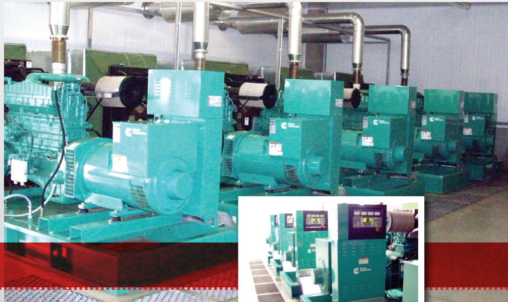
Ao lado, detalhes da instalação com os 5 Grupos Geradores Cummins modelo C400 D6, totalizando uma usina de 2280kVA.
